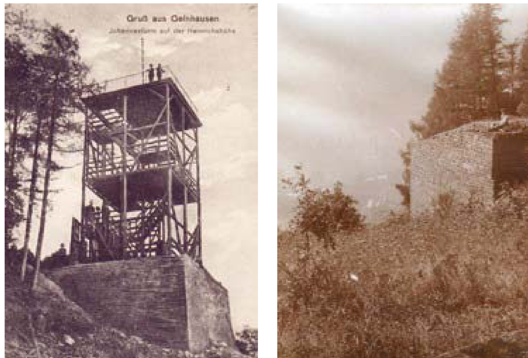
Der Aussichtsturm auf der Heinrichshöhe war aus Holz gefertigt und wurde später aufgrund von Witterungsschäden wieder abgetragen. Unten: Anzeige zur Übergabe des Turms auf der Heinrichshöhe
